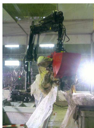
Рисунок 3 – Выгрузка ТРО из ХЖТРО на САЭС краном-манипулятором HIAB
