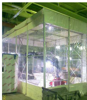
Рисунок 6 – Модуль управления над проёмом перекрытия
